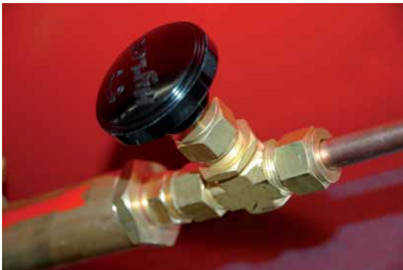
Bild: Dosierventil für Trägergas
