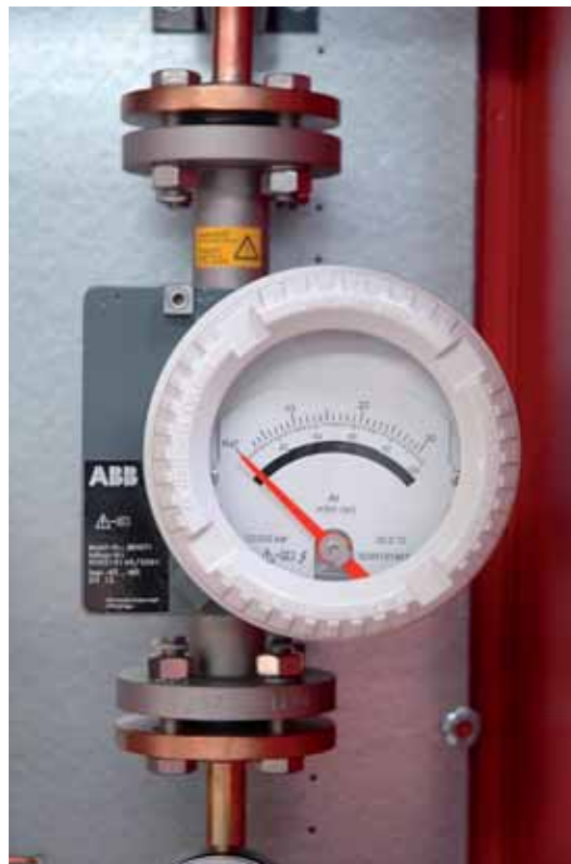
Bild: Durchflussmesser für Trägergas
