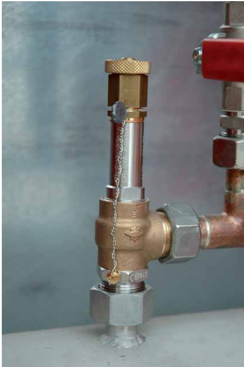
Bild: Sicherheitsventil für Pufferbehälter
