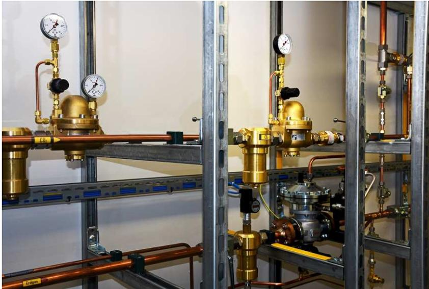
Druckregelung mit LTD-1 Druckregleinheiten
